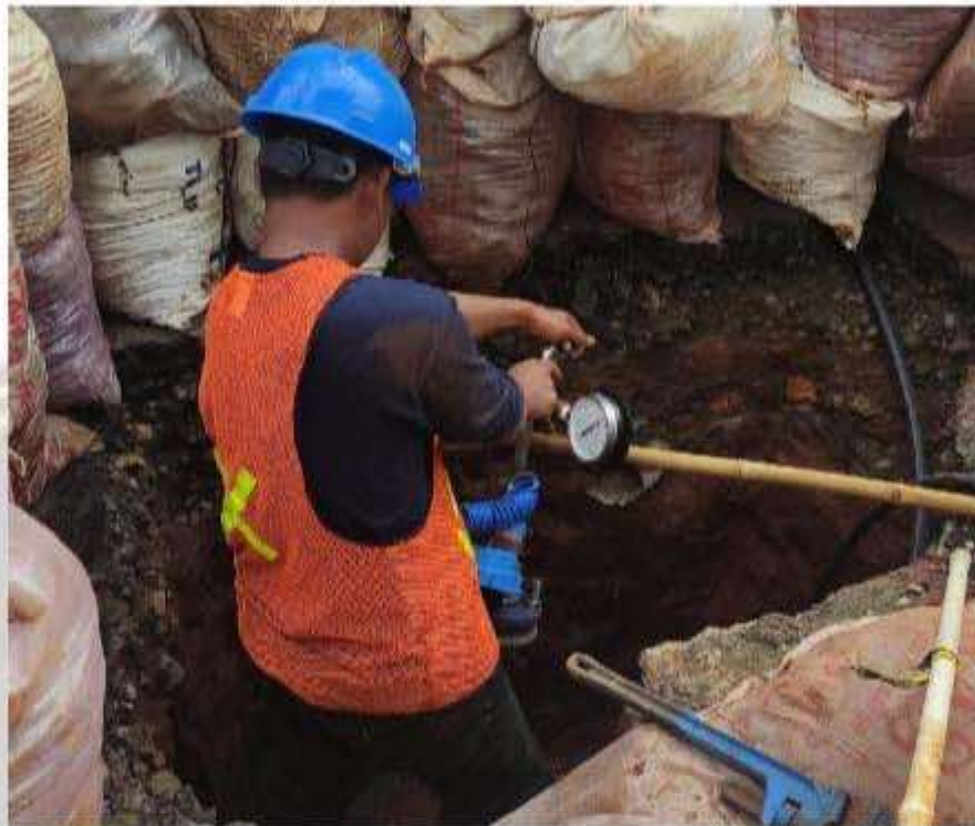
Gambar 2.5 Pekerjaan Boring Horizontal Manual
