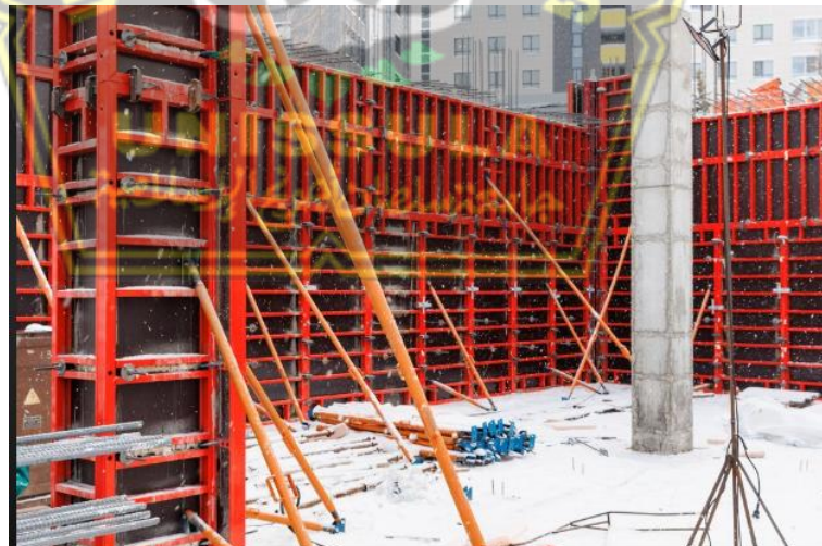
Gambar 2. 8 Bekisting Sistem Penuh (Kolom dan Dinding Beton )
