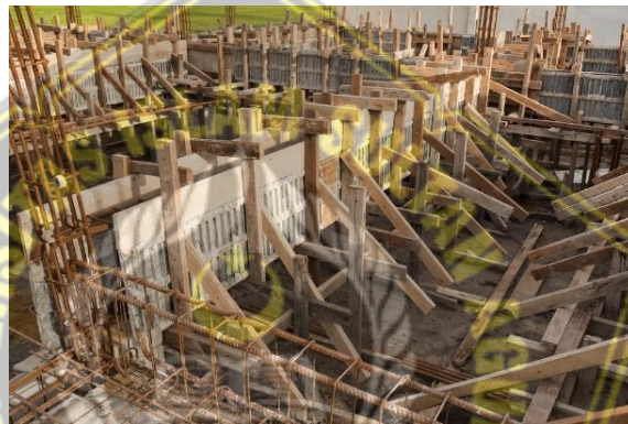
Gambar 2. 3 Bekisting Konvensional
