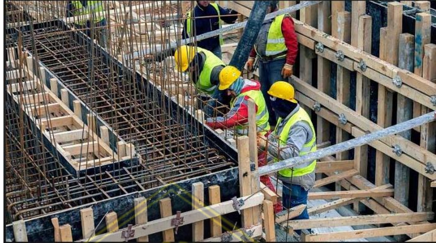
Gambar 2. 5 Bekisting Semi Sistem (Balok dan Plat)
