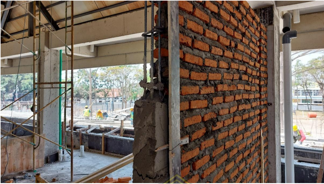
Gambar 4. 12 Pekerjaan Dinding dan Plesteran
