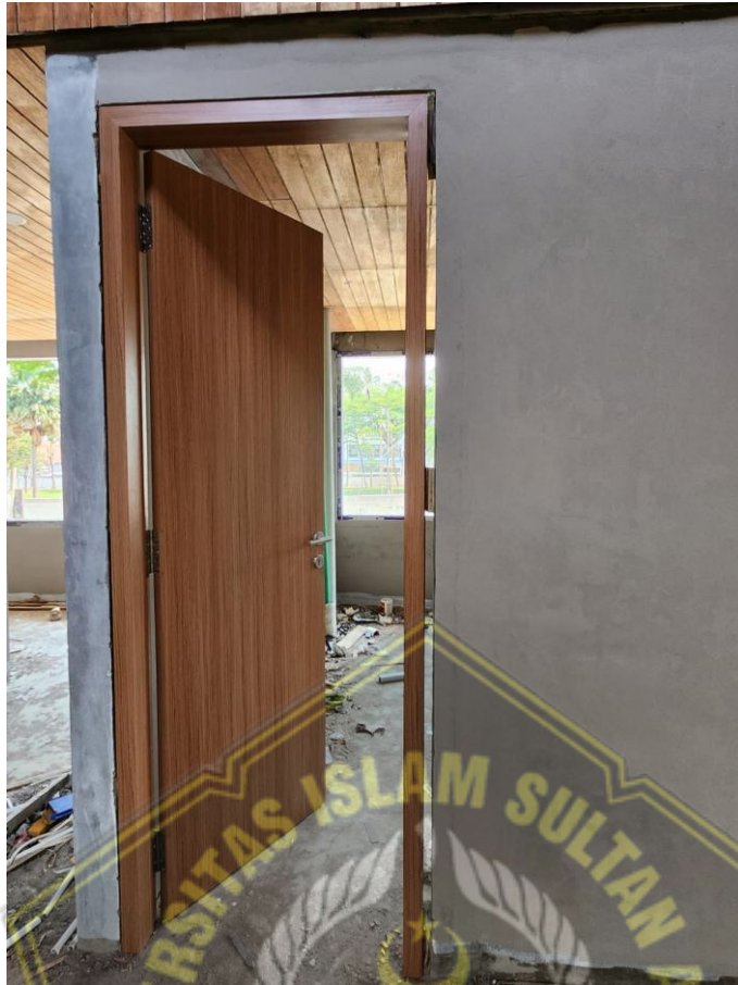
Gambar 4. 14 Pekerjaan Pintu dan Jendela
