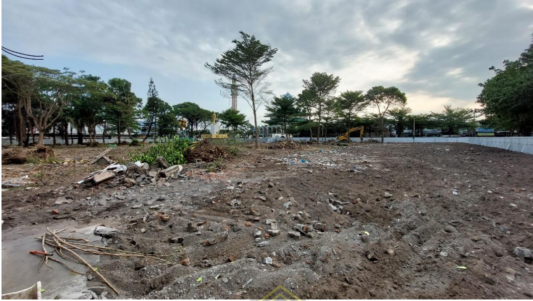
Gambar 4. 10 Pekerjaan Persiapan Lahan
