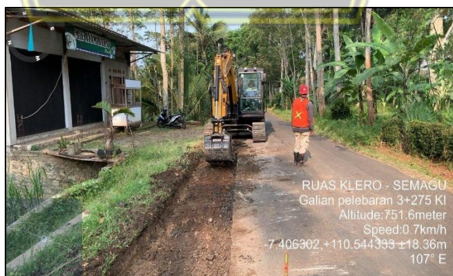
Gambar 4. 7 Pekerjaan Galian Biasa
