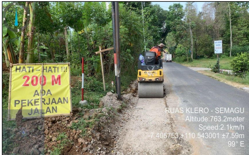
Gambar 4. 8 Pekerjaan Pemasangan Timbunan LPA
