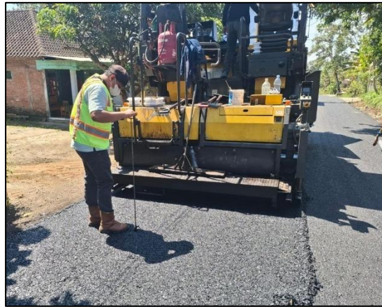
Gambar 4. 9 Pekerjaan Ukur Gembur-Padat Perkerasan
