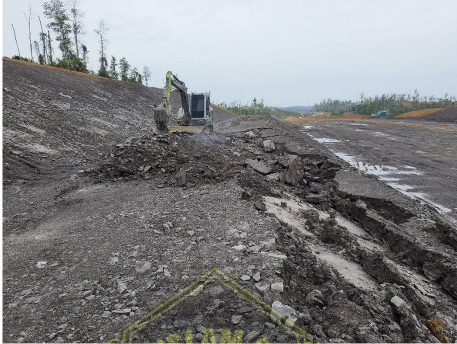
Gambar 3.2 Kondisi Longsoran Dari Atas
