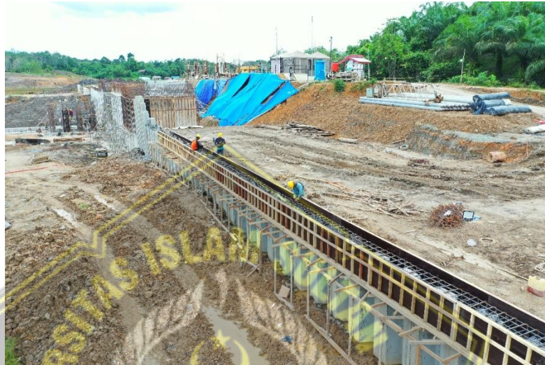
Gambar 4.5 Proses Penulangan dan Bekisting
