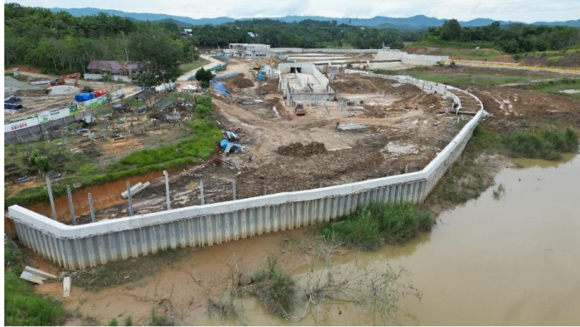
Gambar 4.6 CCSP yang sudah selesai
