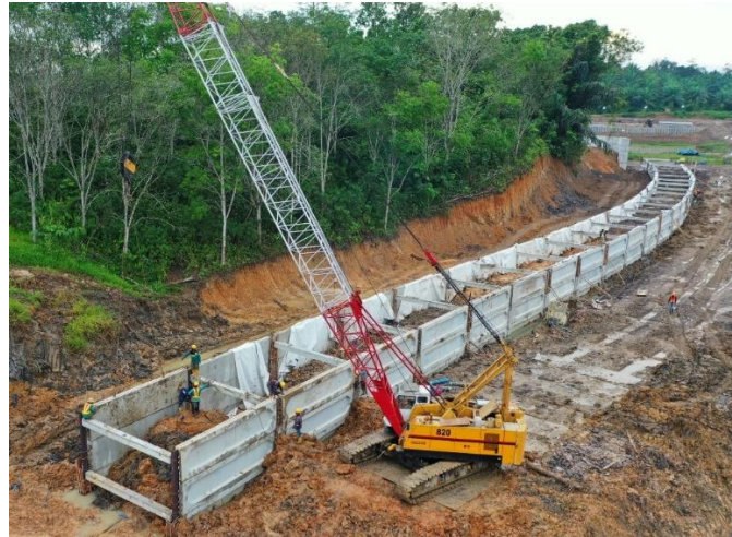
Gambar 4.16 Proses Pemasangan Panel Sisi Atas
