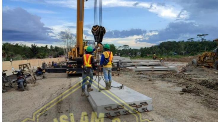
Gambar 4.12 Pengangkutan Panel ke Lokasi Pemasangan
