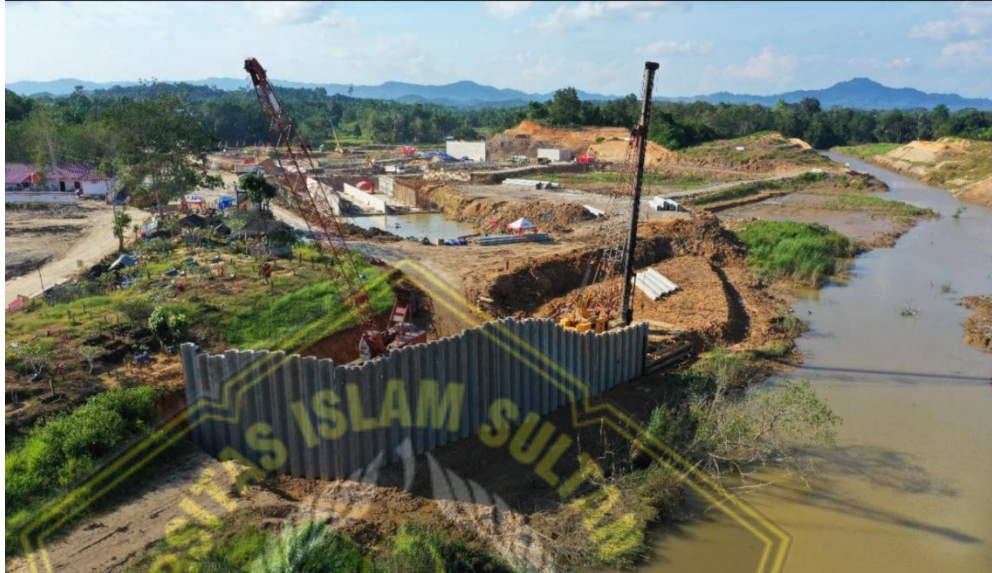
Gambar 4.4 Proses Pemasangan CCSP
