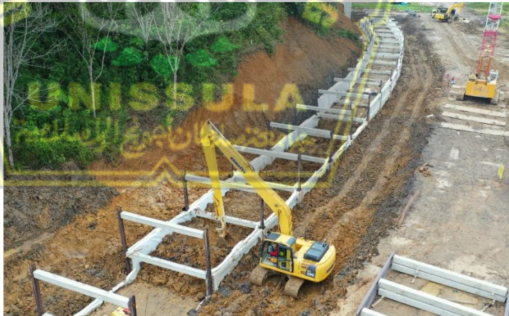
Gambar 4.15 Proses Pengurugan Sisi dalam Concrete Panel
