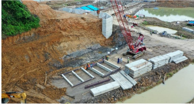
Gambar 4.14 Proses Pemasangan Interlock Panel
