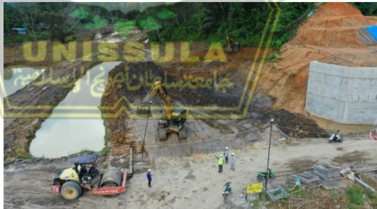
Gambar 4.13 Proses Galian Tanah Lokasi Pemasangan
