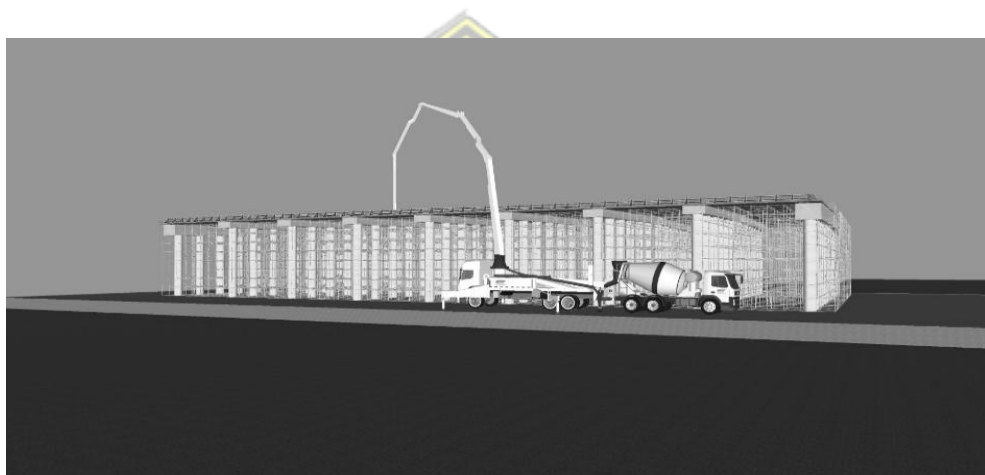
Gambar 2.1 Ilustrasi Pekerjaan Pengecoran
