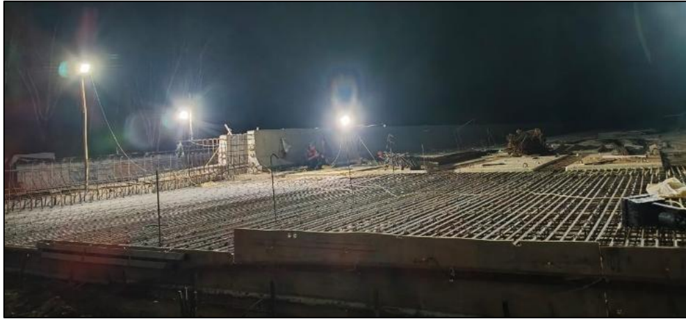
Gambar 4.9 Pembesian Slab
