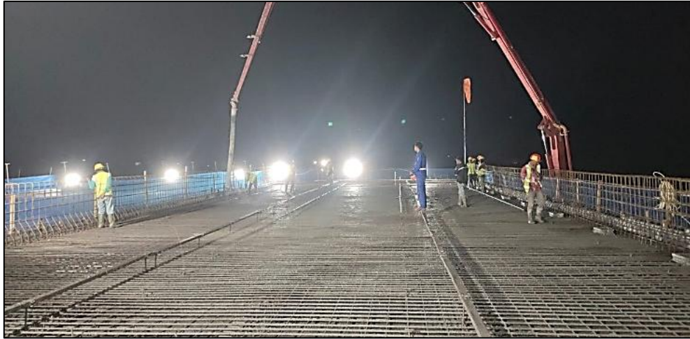
Gambar 4.10 Pengecoran
