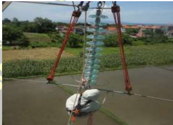
Gambar 4 7 Pemasangan Isolator Baru Jenis Kaca dengan Lapisan Zinc Sleeve
