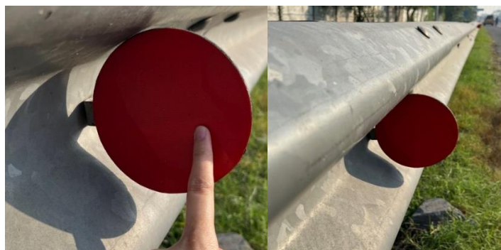
Gambar 4. 15 Guardrail Reflektor di KM 15 – 16 Jalur B
