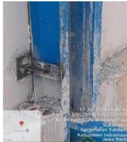
Gambar. 2.3 Membaca Bukaan Pintu Sumber: Buku Saku Operasi Pintu Air (RIMP, 2024)
