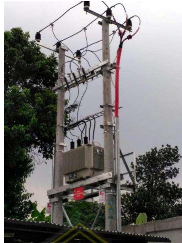
Gambar 2. 9 Saluran Udara Tegangan Menengah [Dokumen Pribadi]
