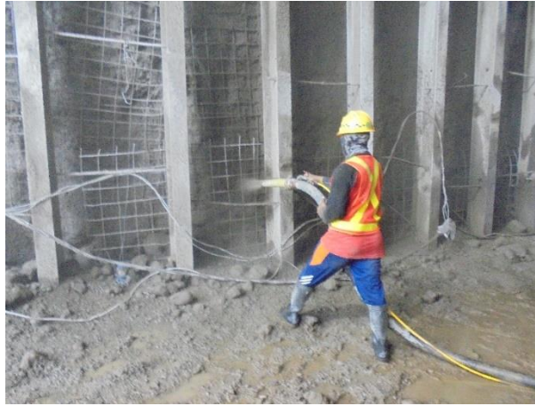
Gambar 2.8 Penyemprotan Shotcrete (Sumber: Dokumentasi Proyek, 2022)
