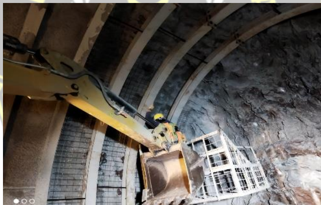
Gambar 2.6 Pemasangan Wiremesh (Sumber: Dokumentasi Proyek, 2023)
