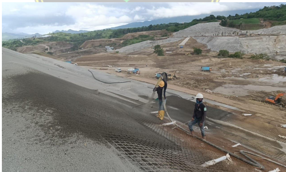
Gambar 4.5 Pekerjaan Shotcrete (Sumber: Dokumentasi Lapangan, 2022)
