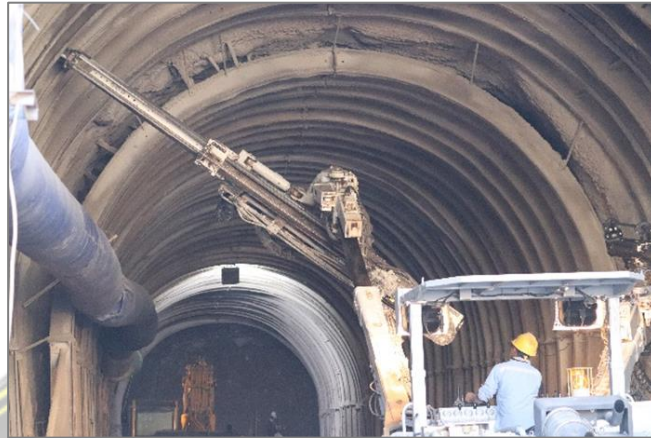
Gambar 2.7 Pengeboran untuk Pemasangan Rockbolt (Sumber: Dokumentasi Proyek, 2023)
