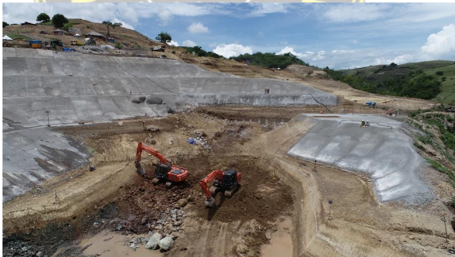
Gambar 4.3 Galian Inlet Terowongan Pengelak (Sumber: Dokumentasi Lapangan, 2022)
