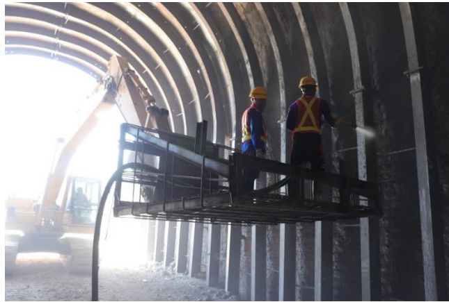
Gambar 2.5 Penjemputan Shotcrete (Sumber: Dokumentasi Proyek, 2023)
