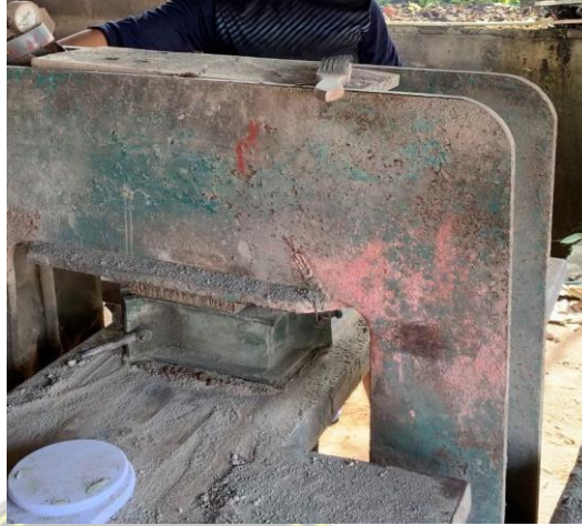
Gambar 3.15 Proses Pembuatan Paving Block
