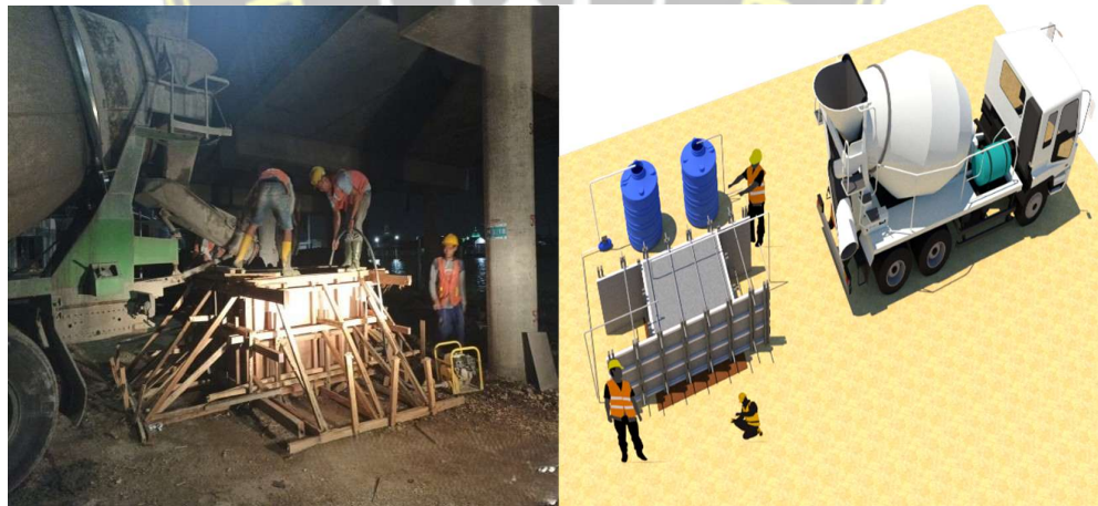
Gambar 4.23. Pencampuran Beton Untuk Mock Up
