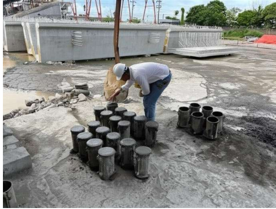
Gambar 4.15. Proses Pembuatan Sampel Benda Uji Beton Job Mix Design
