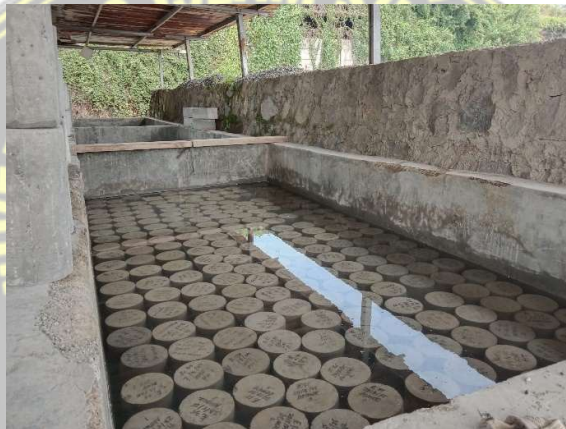
Gambar 4.16. Pelaksanaan Perawatan Beton Dengan Bak Curing
