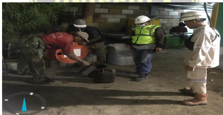
Gambar 4. 2 Pengambilan Material Aspal dan Stripping Agent Sumber : Dokumentasi Pribadi
