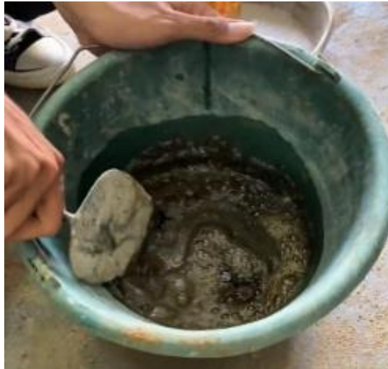
Gambar 3. 1 Pencampuran mortar busa ( Sumber : Dokumen penulis, 2025 )
