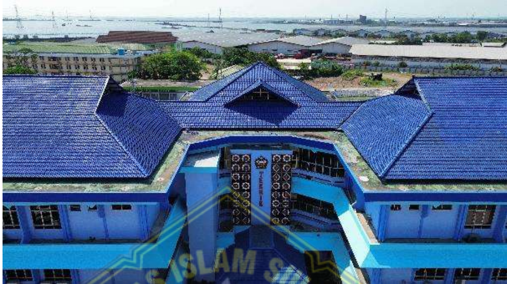
Gambar 4. 3 Tampak Depan Gedung Fakultas Teknik Unissula
