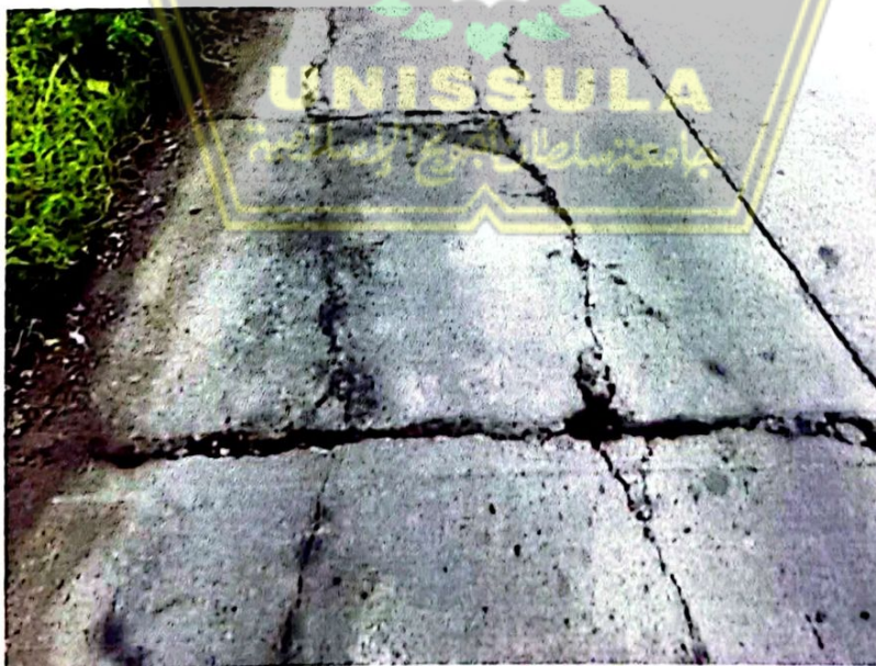
Gambar 4.13. Pelat terbagi ( Devided Slab )
