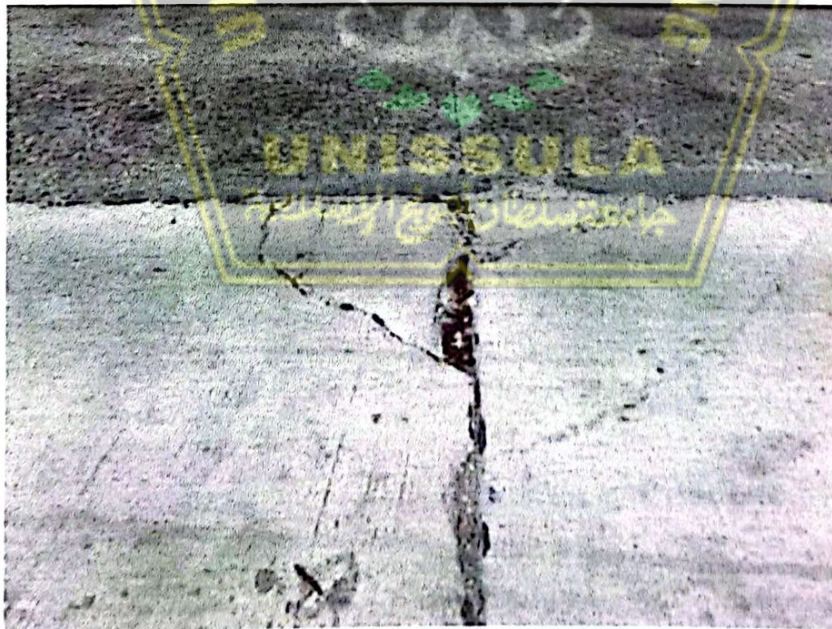
Gambar 4.16. Retak Pojok
