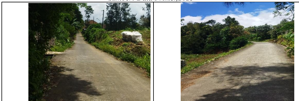
Gambar 3.4 Kondisi Jalan Penghubung Desa
