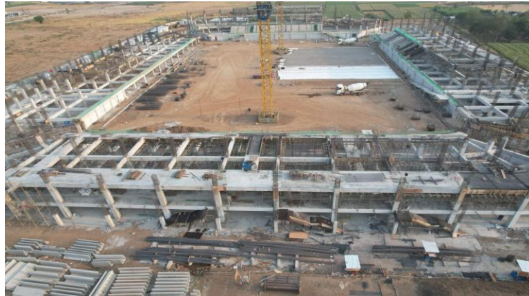
Gambar 4. 11 Pekerjaan Struktur Tribun
