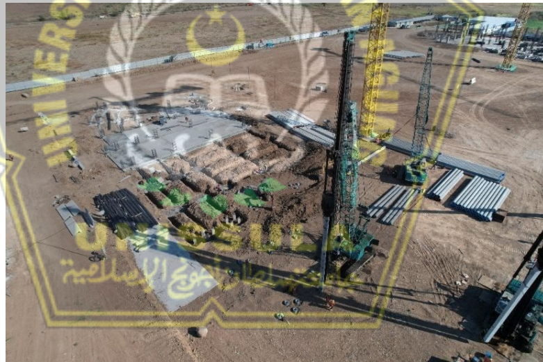
Gambar 4. 10 Pekerjaan Pemancangan
