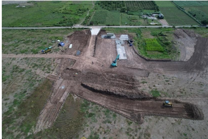
Gambar 4. 9 Pekerjaan leveling
