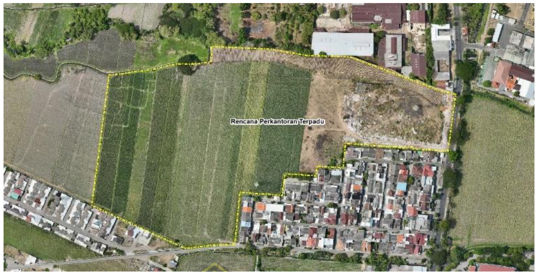
Gambar 4.8 Kondisi eksisting lokasi penelitian
