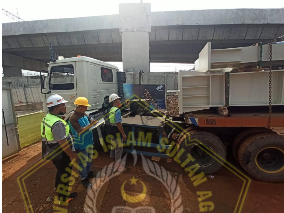
Gambar 4. 18 Proses Pengecekan Material yang Datang (Sumber : Dokumentasi Proyek Manggarai Main Line I, 2025)
