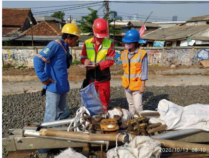
Gambar 4.16 Proses Maintenance Peralatan yang Digunakan (Sumber : Dokumentasi Proyek Manggarai Main Line I, 2025)
