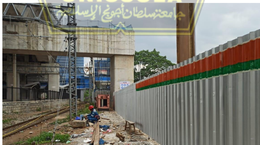
Gambar 4. 9 Pelaksanaan Proteksi Pekerjaan
