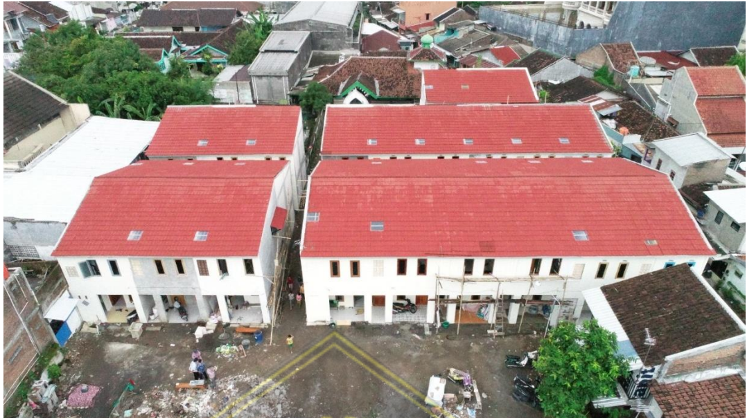
Gambar 4. 2 Foto Udara Progres Pembangunan relokasi Kampung Blangkon
