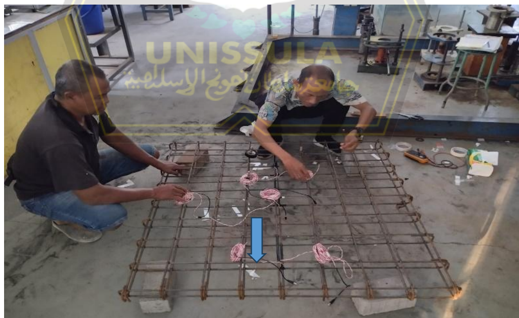
Gambar 4. 7 Pemasangan Strain gauge Pelat Perkerasan
