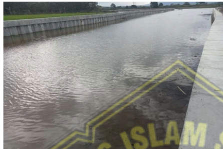
Gambar 2. 3. Tanggul Sungai (Dokumentasi Penulis)
