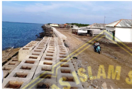
Gambar 2. 5. Tanggul Laut Eretan Indramayu (Dokumentasi Penulis)
