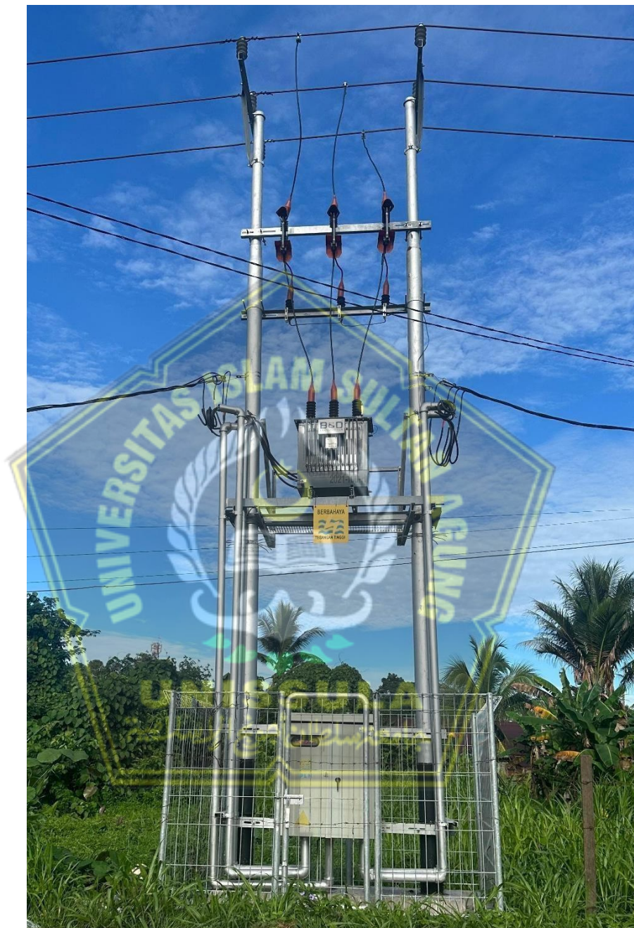
Gambar 4. 4. Foto Gardu Distribusi Sisipan NBR 287
