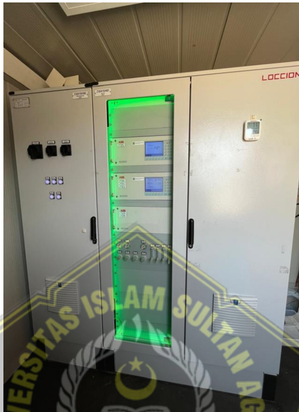
Gambar 2.2 CEMS Analyzer PLTGU PT Jawa Satu Power
