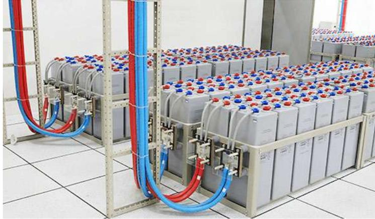
Gambar 2.5 Komponen Baterai pada PLTS
