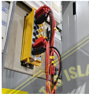
Gambar 3. 9 Test Plug dipasang pada Test Block
