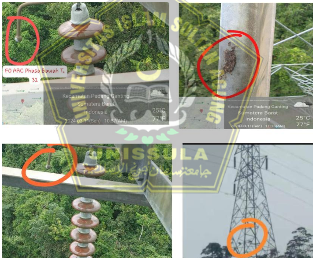
Gambar 4.26 Eviden lapangan gangguan PHT Ombilin-Batusangkar 2
