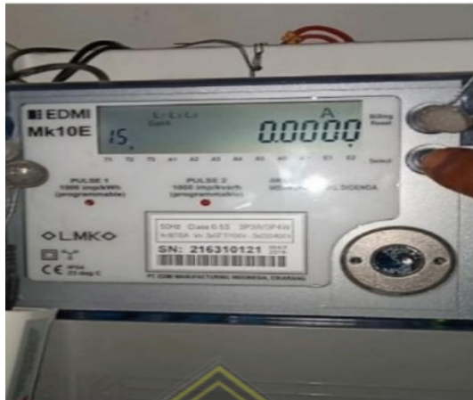
Gambar 4.9 Arus Pada kWh Meter CV Sumber Dingin Tidak Terukur
