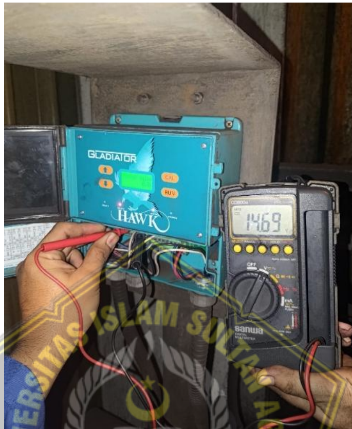
Gambar 4. 2. Hasil Pengukuran Tegangan Sender Kondisi Chute Normal
