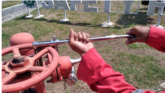
Gambar 4.10 Penggunaan Universal F-Key Dalam Operasional Gate Valve
