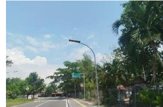
Kondisi lampu jalan pada lokasi peneltian
