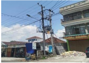
Kondisi SUTM pada lokasi peneltian
