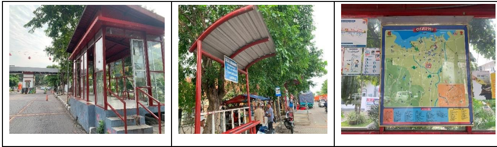
Gambar 4. 38 Kondisi Fasilitas Halte
