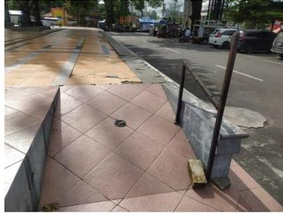
**Gambar 4. 59 Kerusakan Pegangan Pada Ramp**
