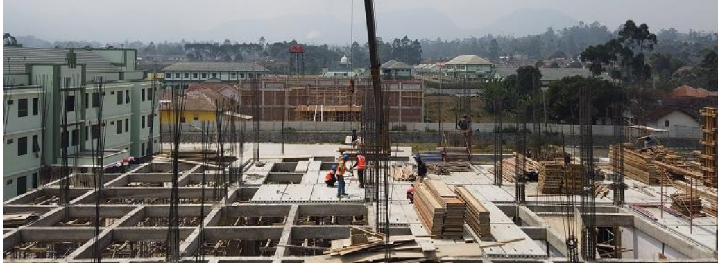
Gambar 4.18 Pelaksanaan Pelat HCS (Sumber: Beton Elemenindo Perkasa)
