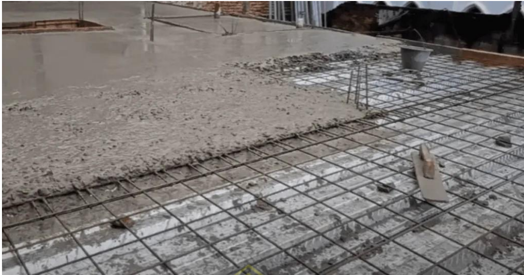
Gambar 4.24 Pelat Komposit Baja-Beton
