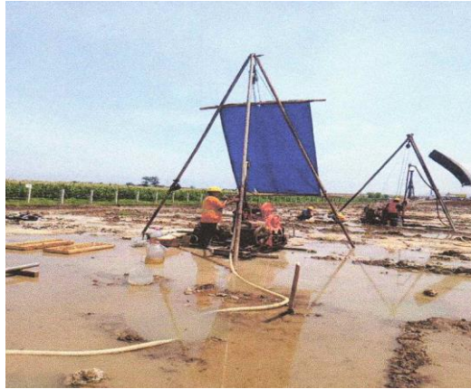
Gambar 4.10 Pekerjaan coring untuk pengambilan sampel benda uji
