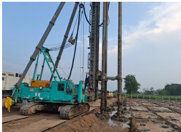
Gambar 4.4 Pekerjaan DCM oleh PT Leekang Jaya Konstruksi
