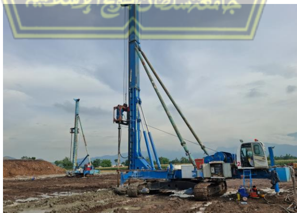
Gambar 4 5 Pekejaan DCM oleh PT Geotekindo
