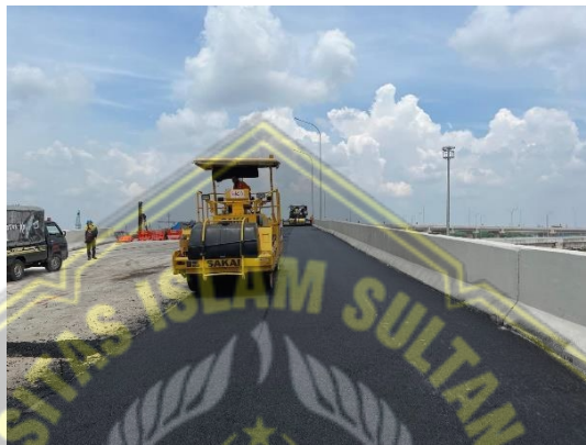
Gambar 4. 12 Pemadatan Aspal dengan Tandem Roller
