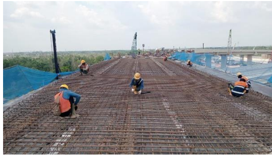
Gambar 4. 4 Proses Pembesian Lantai
