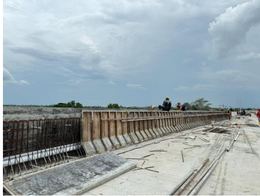
Gambar 4. 8 Proses Pemasangan Bekisting
