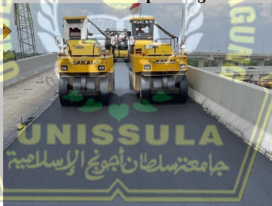
Gambar 4. 13 Pemadatan Aspal dengan PTR
