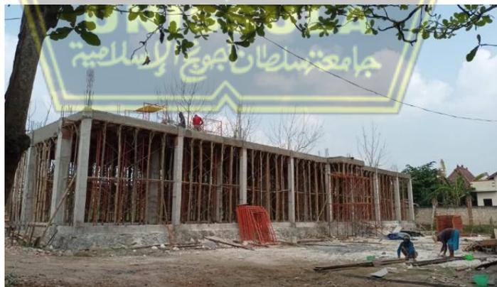
**Gambar 4.8** Pekerjaan Kolom dan Balok
