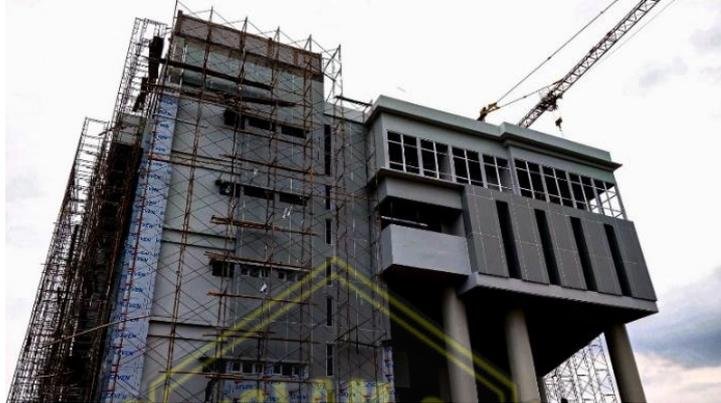
**Gambar 4.5** Pekerjaan Dinding dengan Finishing Cat
