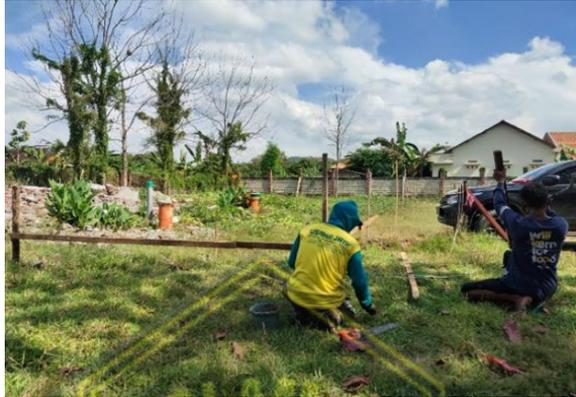
**Gambar 4.7** Pekerjaan Persiapan Pemasangan Bouwplank
