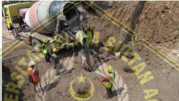
**Gambar 4.13** Pengecoran Pondasi *Bore Pile*
