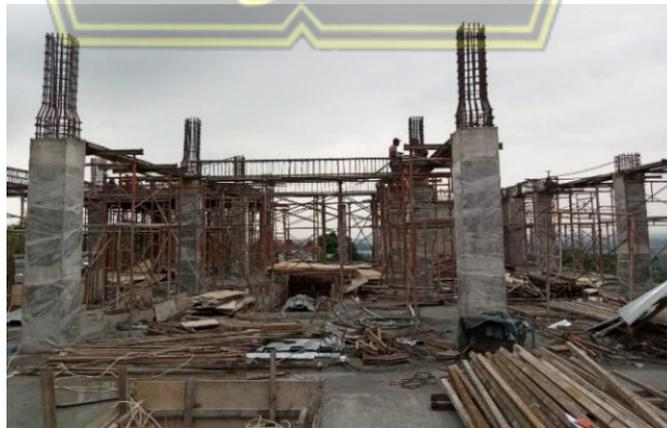
**Gambar 4.14** Pekerjaan Beton Bertulang Kolom
