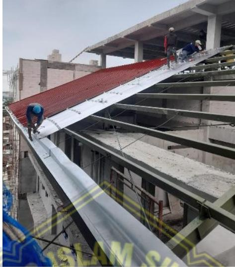
**Gambar 4.15** Pekerjaan Pemasangan Insulasi dan Penutup Atap
