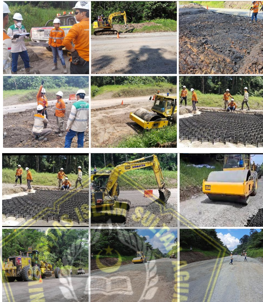
Gambar 4.13 Dokumentasi Pekerjaan Metode Geocell
