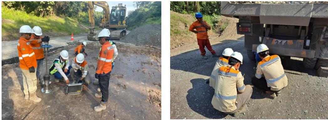
Gambar 3.5 Pengujian CBR Lapangan
