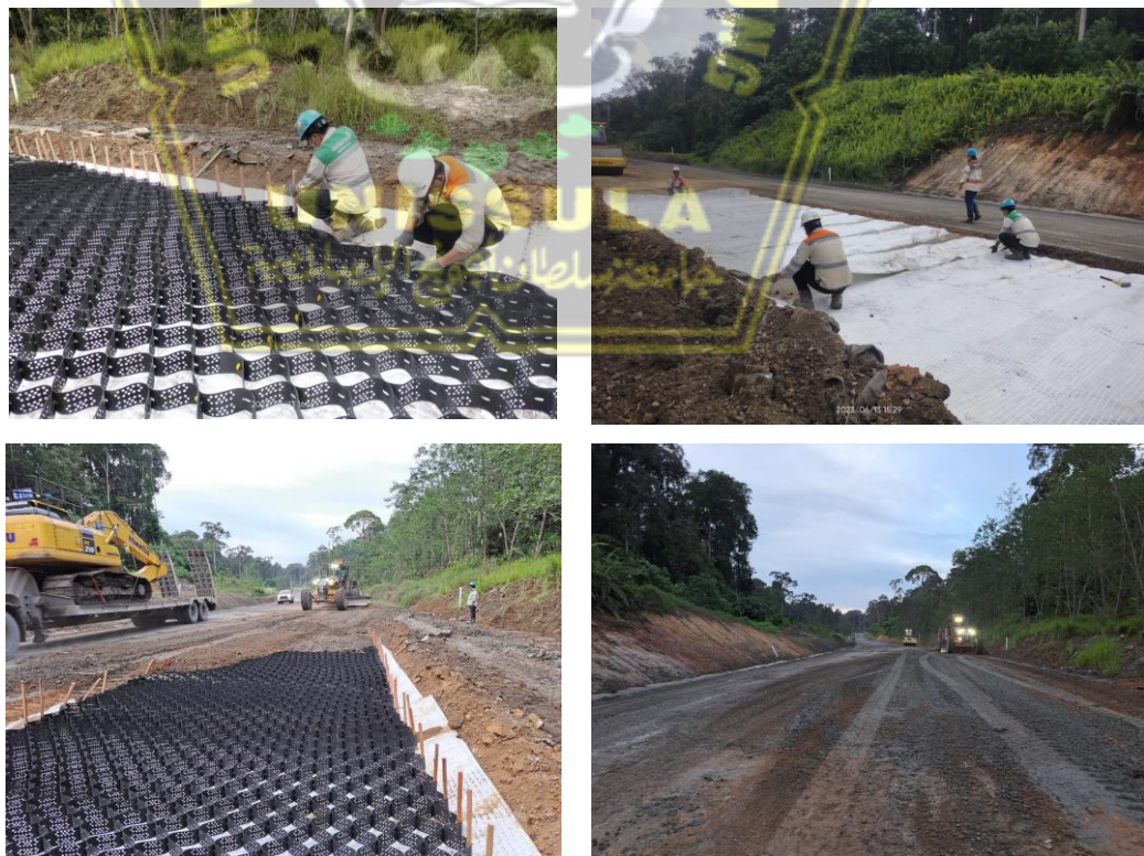
Gambar 3.6 Proses Penerapan Geocell di Jalan Hauling
