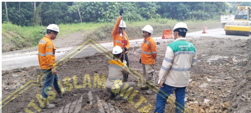
Gambar 4.9 Dokumentasi Uji DCP KM 42+200
