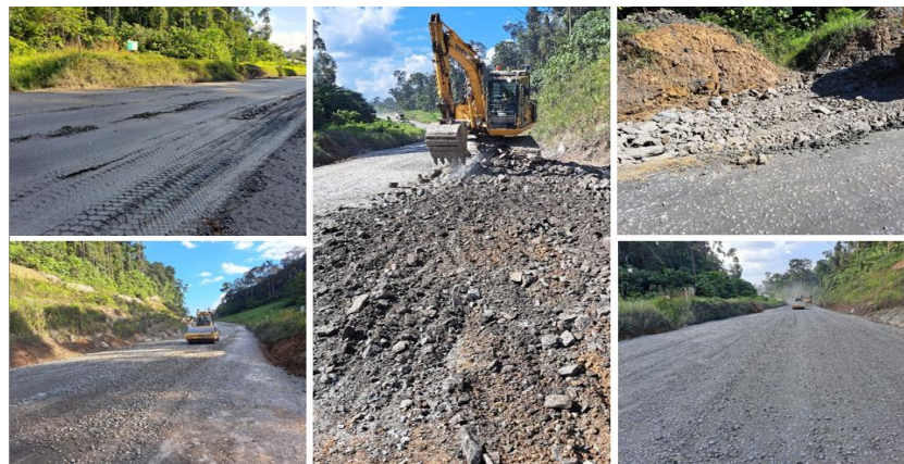
Gambar 4.12 Dokumentasi Pekerjaan Metode Patching
