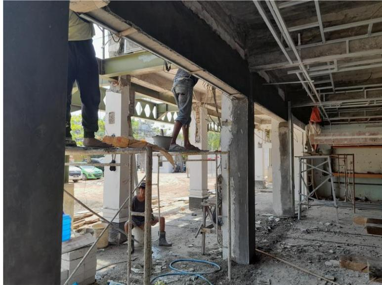
Gambar 4.16 Dilatasi Antara Kolom Beton Lama (Eksisting) dan Kolom Beton Baru
