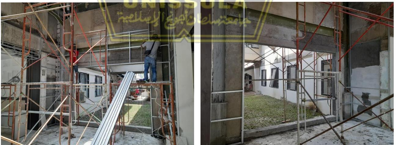
Gambar 4.12 Penyatuan Bangunan Lama (Eksisting) dan Bangunan Baru dengan Metode Dilatasi Joint (Sumber : Foto Pribadi)
