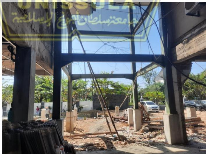
Gambar 4.15 Dilatasi Pada Kolom (Terpisah Antara Kolom Beton Lama dan Kolom Baja IWF Baru) (Sumber : Foto Pribadi)
