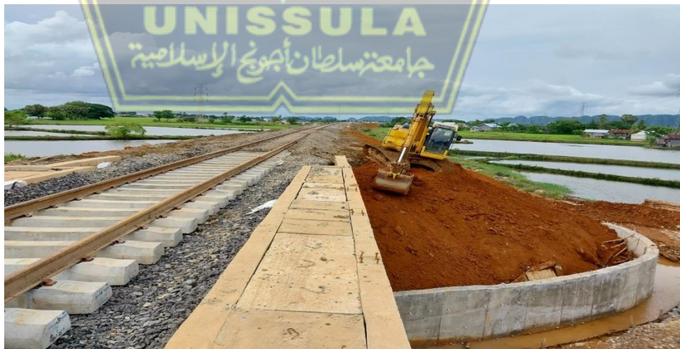
Gambar 4.12 Pekerjaan Talud jembatan di badan jalan kereta api
