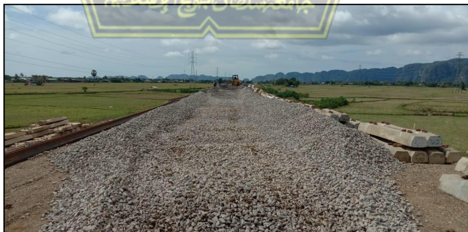
Gambar 4.9 Progres Pekerjaan ballast di badan jalan
