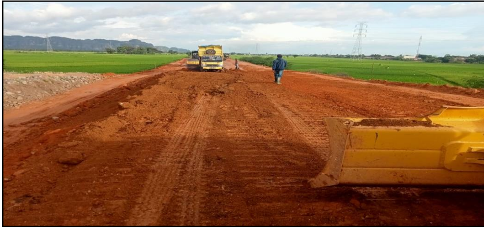
Gambar 4.7: Progres Pekerjaan Timbunan badan jalan kereta api
