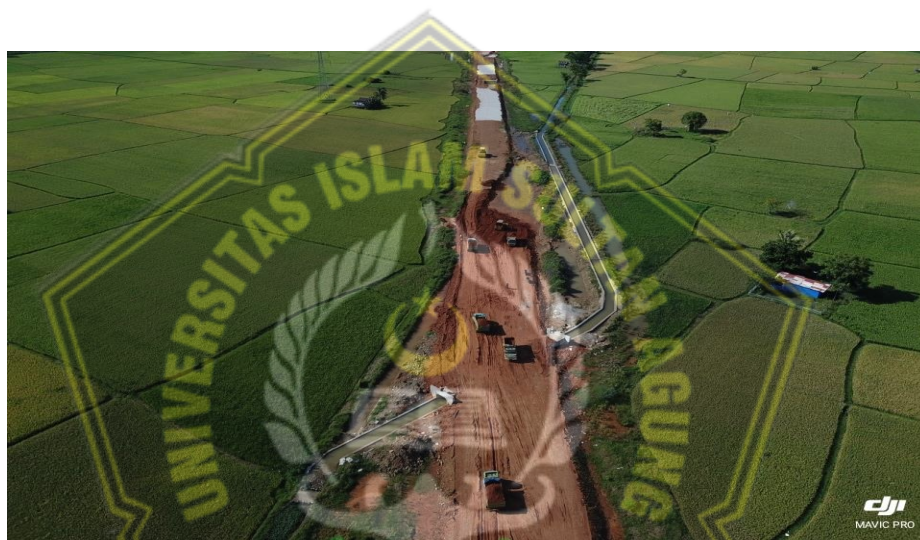
Gambar 4.5: Pek. Timbunan diareal persawahan untuk badan jalan
