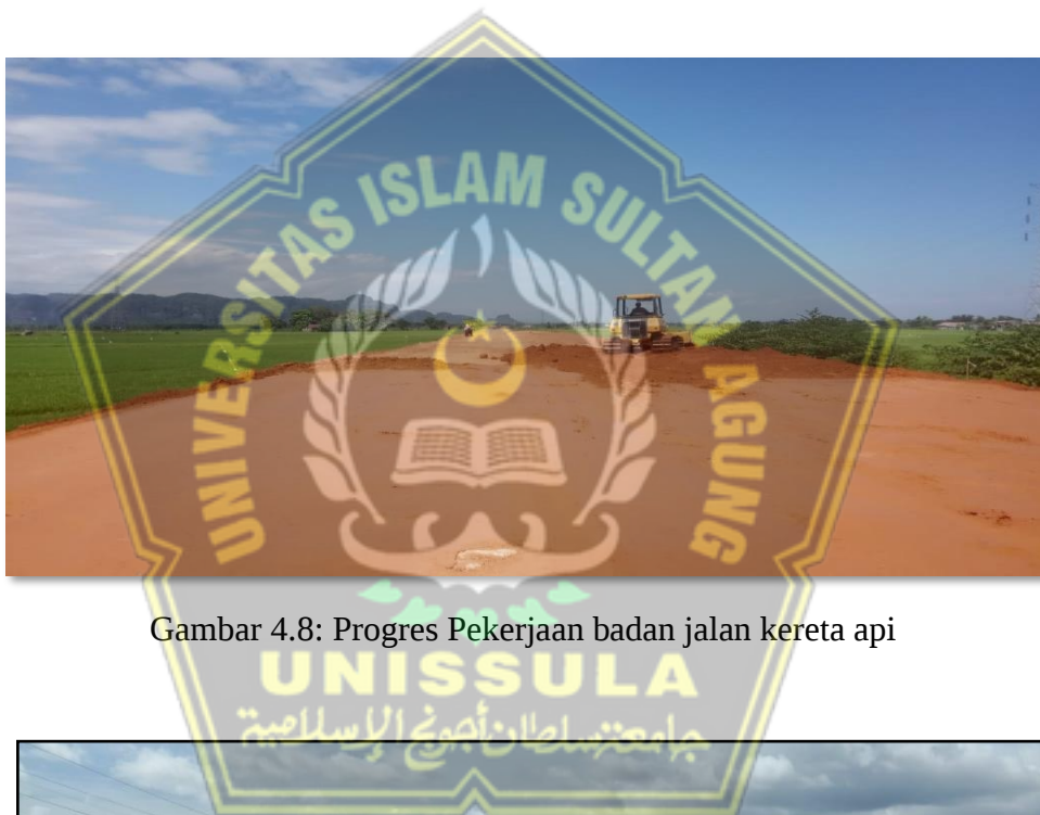
Gambar 4.7: Progres Pekerjaan Timbunan badan jalan kereta api
