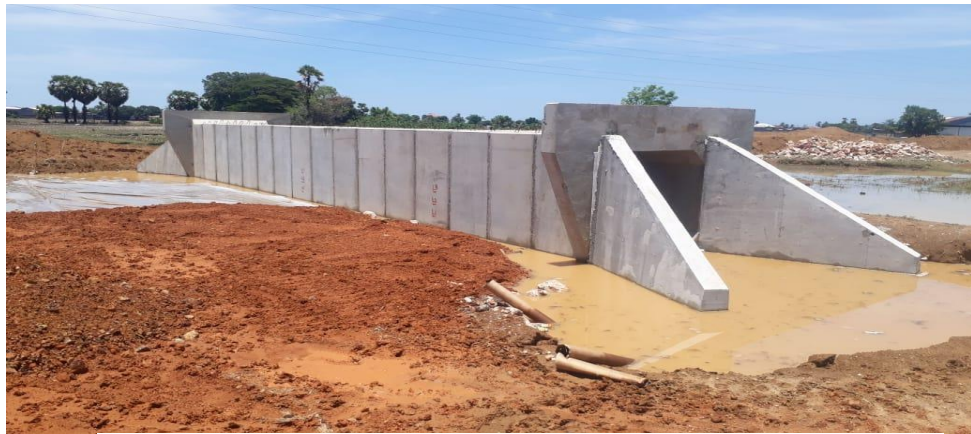
Gambar 4.10 Pekerjaan box culvert di badan jalan kereta api
