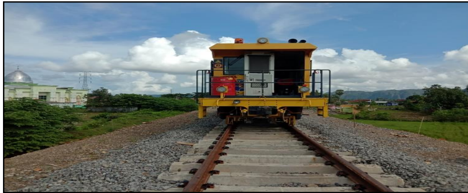
Gambar 4.13 Pekerjaan MTT di jalan kereta api
