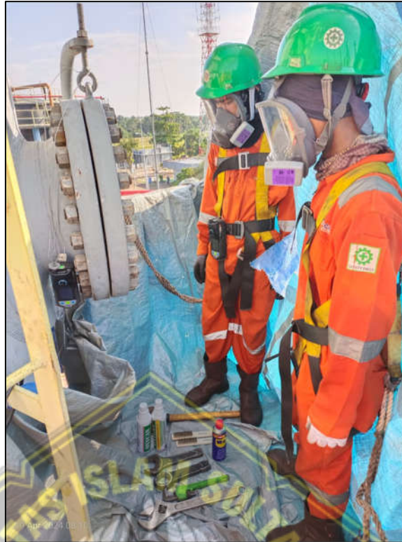
Gambar 4.4 Pekerjaan Open Manhole untuk dilakukan pembersihan
