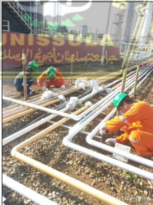
Gambar 4.7 Pekerjaan Pemasangan pipa
