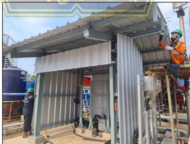
Gambar 4.2 Pekerjaan pemasangan shelter panel
