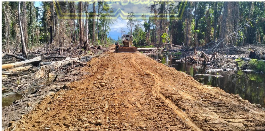
Gambar 3.2. Lokasi Proyek Pembangunan Jalan Poros Karadiri
