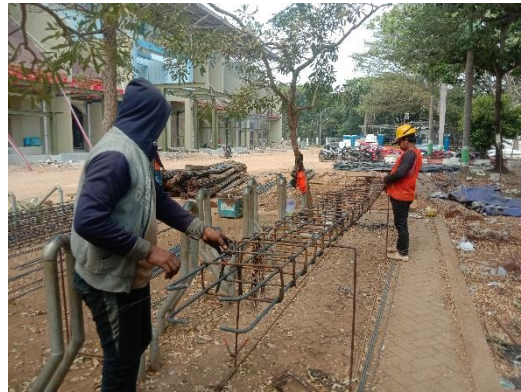
Gambar 4.9 Contoh Lingkup Pekerjaan Pembesian
