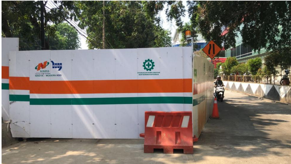
Gambar 1.2 Proyek konstruksi jaringan pipa air limbah JSDP paket 5 zona 1
