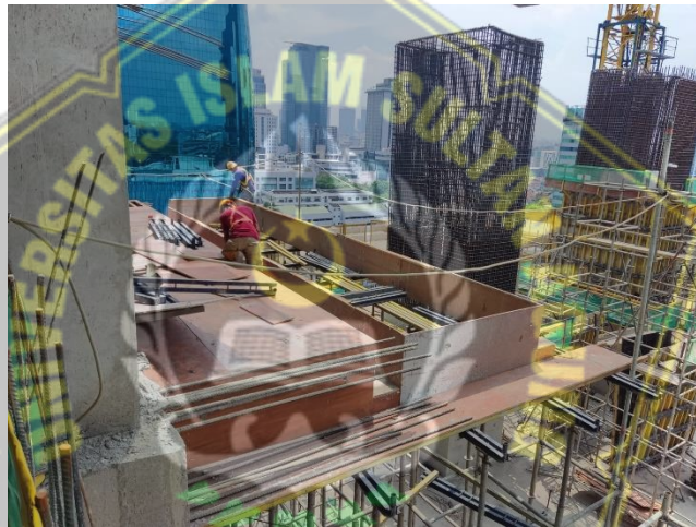
Gambar 2.2 Bekisting Konvensional
