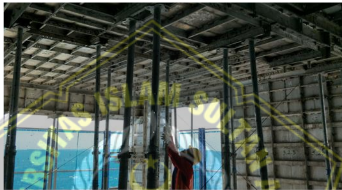
Gambar 2.11 Pemasangan Bekisting Horizontal
