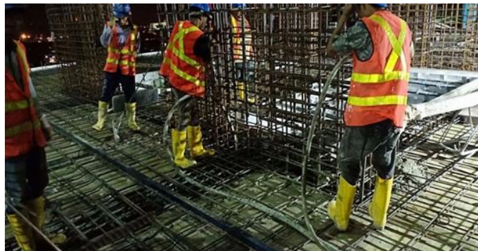
Gambar 2.14 Pengecoran
