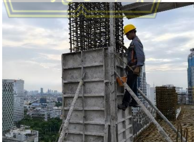
Gambar 2.10 Pemasangan Bekisting Vertikal
