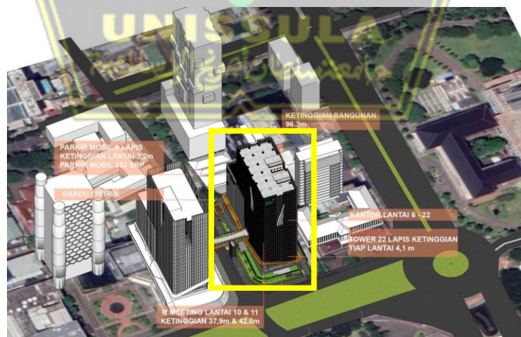
Gambar 3.1 Lokasi Proyek Pembangunan BSI Tower (Sumber : Dokumentasi Proyek BSI Tower Jakarta, 2024)
