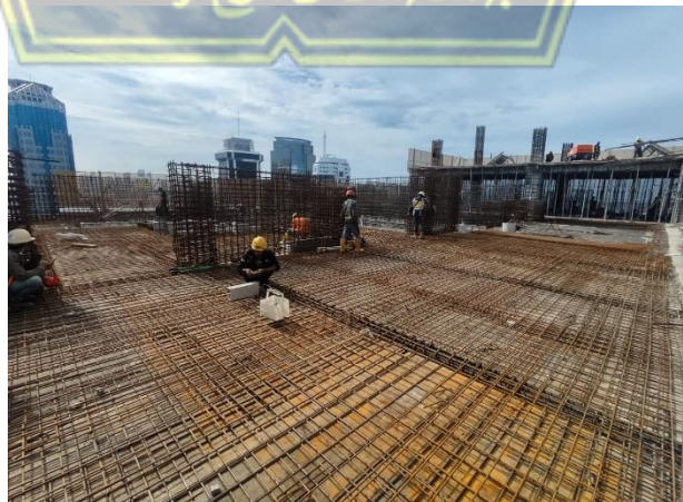
Gambar 2.12 Pemasangan Pembesian Horizontal
