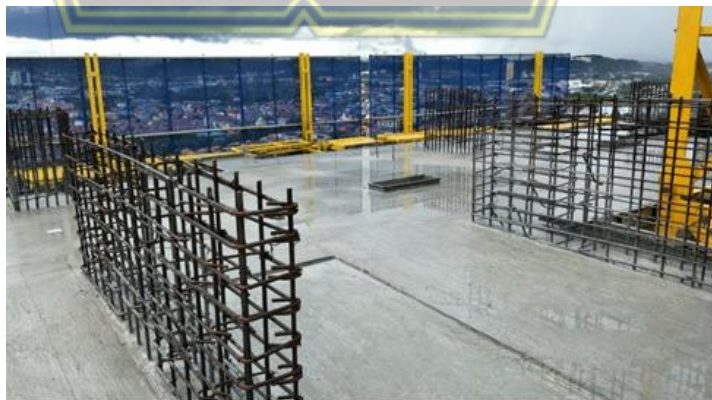
Gambar 2.6 Marking Pekerjaan Bekisting (Sumber : Dokumentasi Proyek BSI Tower Jakarta, 2024)
