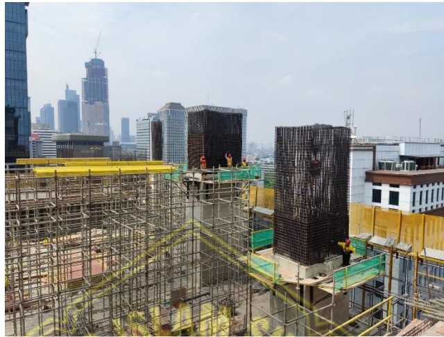
Gambar 2.7 Pemasangan Pembesian Vertikal
