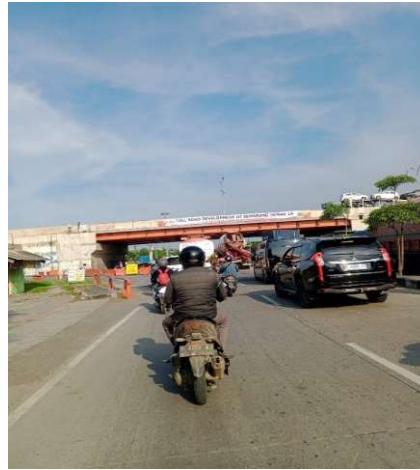
Gambar 4.4. Kondisi jalur arah Demak
