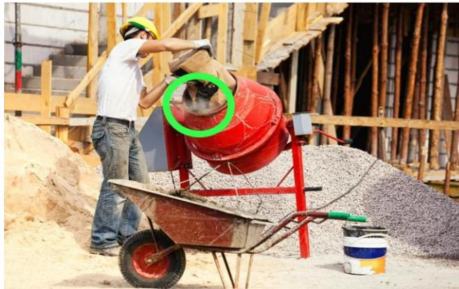
**Gambar 4. 14** Debu Semen Ketika Pencampuran Bahan Beton
